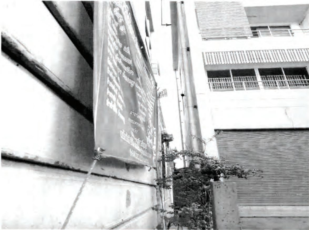
ภาพถ่ายวางระบายน้ำด้านข้างของอาคาร
