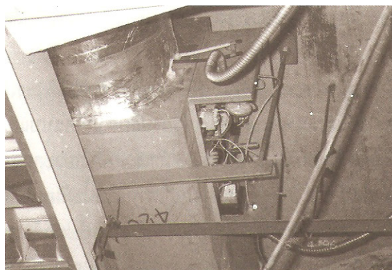
รูปที่ 23 ชุดควบคุมของกล่อง VAV
