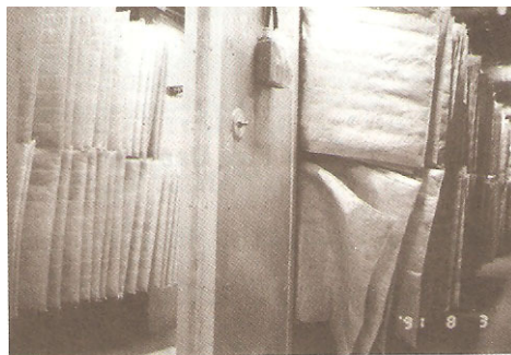
รูปที่ 46 แผงกรองอากาศ
