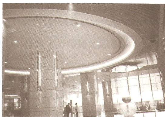
รูปที่ 41 SLOT DIFFUSER แบบโค้ง
