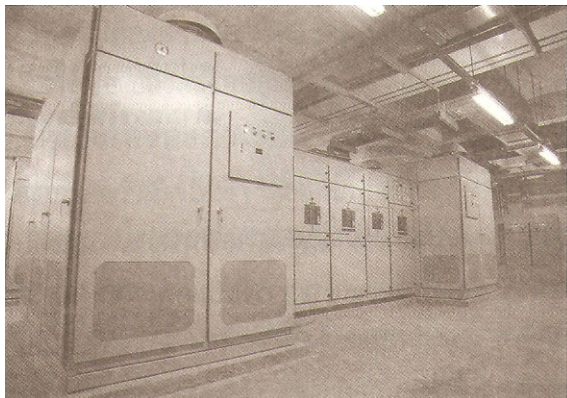
รูปแสดง Substation ชนิดมีตู้หม้อแปลง
