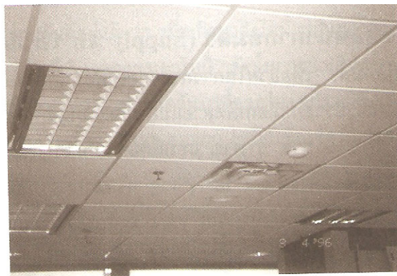
รูปที่ 42 หัวจ่ายลมเย็นและช่องลมกลับข้างโคมไฟ
