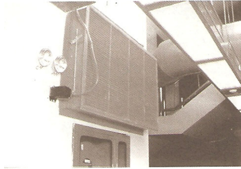
รูปที่ 45 ช่องดูดควันไฟ
