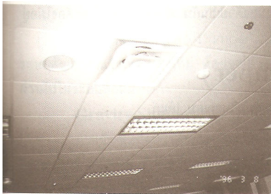
รูปที่ 40 หัวจ่ายลมที่เหมาะสมสำหรับระบบ VAV
