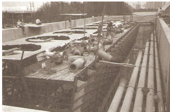
รูปที่ 32 หระบายความร้อนระหว่างการติดตั้ง
