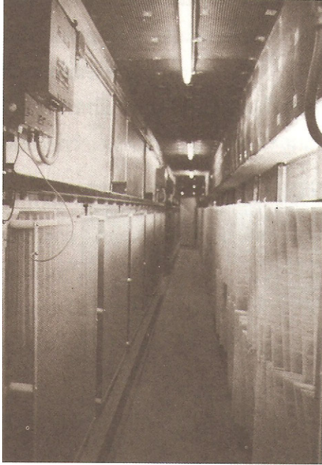
รูปที่ 47 เครื่องฟอกอากาศ (ซ้าย) และแผงกรองอากาศ (ขวา)
