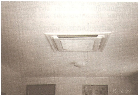
รูปที่ 7 เครื่องปรับอากาศแบบ CASSETTE TYPE
