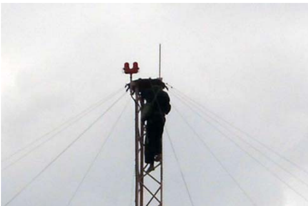
ซ่อมไฟยอดเสา TOWER โยทะกา จ.ชลบุรี
