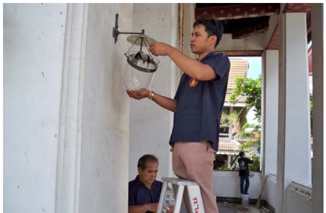
กฟฟ.ชย.ทร. ซ่อมทำระบบไฟฟ้าให้กับวัดระฆัง
