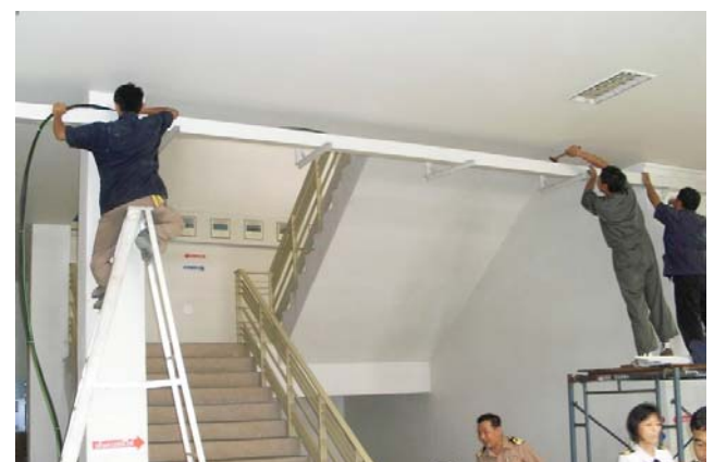
งาน เดินสายไฟฟ้ากำลัง ยศ.ทร.
