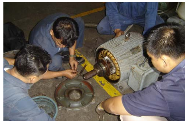
งานซ่อมทำเครื่องสูบน้ำ ขว.ทร.
