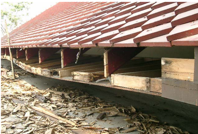
งาน ซ่อมทำหลังคาเชิงชาย อาคารราชนาวิกสภา
