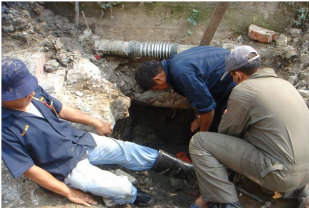
ซ่อมเปลี่ยนท่อโสโครก กองควบคุมคุณภาพ อร.
