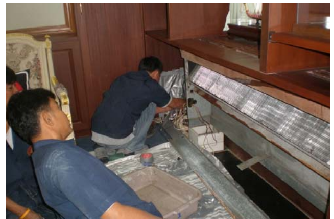
รง.เครื่องเย็นฯ กคก.ชย.ทร.ซ่อมบำรุงและล้างทำความสะอาดเครื่องปรับอากาศ ขนาด ๔๕,๐๐๐ บีทียู ที่ห้อง ผบ.ทร.
