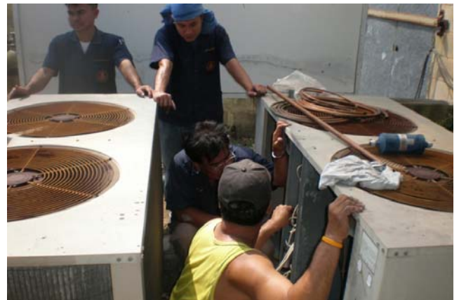
รง.เครื่องเย็นฯ กคก.ชย.ทร.ซ่อมบำรุงเครื่องปรับอากาศขนาด ๕๓,๐๐๐ บีทียู จำนวน ๒ ชุดเครื่อง ที่ กองช่างโยธา รฐท.สส. โดยเปลี่ยนCompressorและอุปกรณ์ที่ชำรุดหลายรายการ ขณะนี้เครื่องใช้ราชการได้ปกติ
